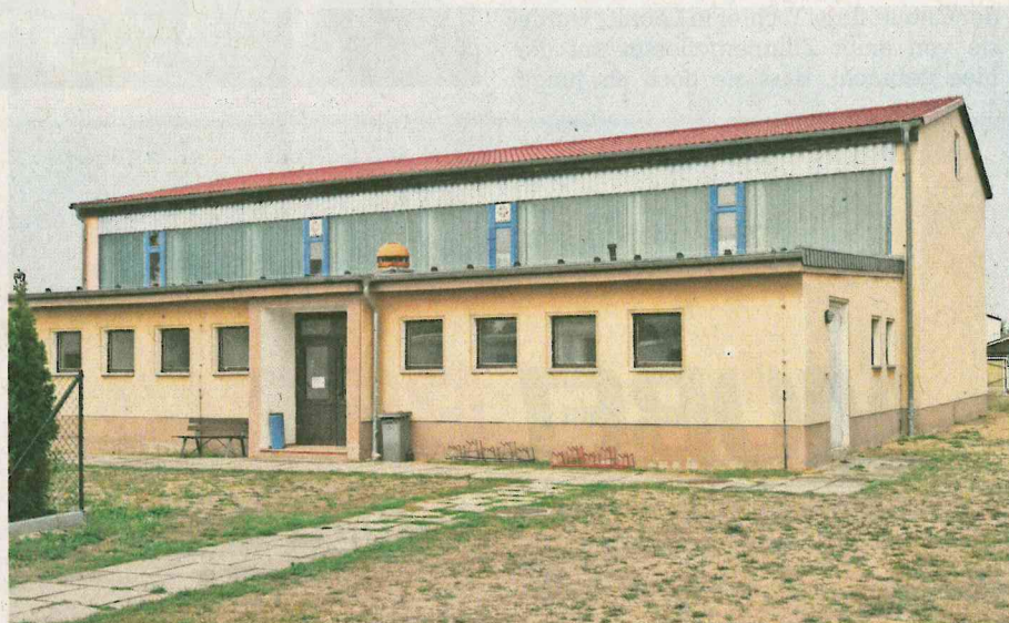
Der Sportverein Zschepplin hat die Halle zum 1. September übernommen und will sie grundlegend sanieren.
